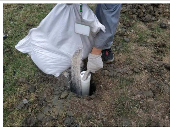
地下水监测井填充滤料石英砂
