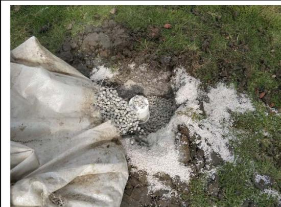
地下水监测井填充止水材料膨润土
